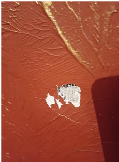
Механические повреждения
